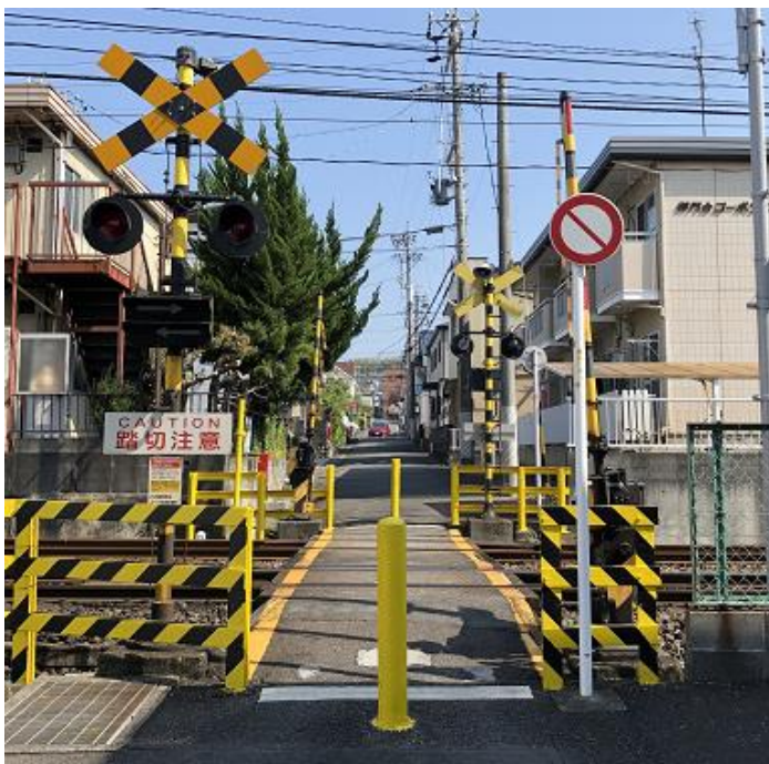
施工前：七ツ新屋第1踏切道
