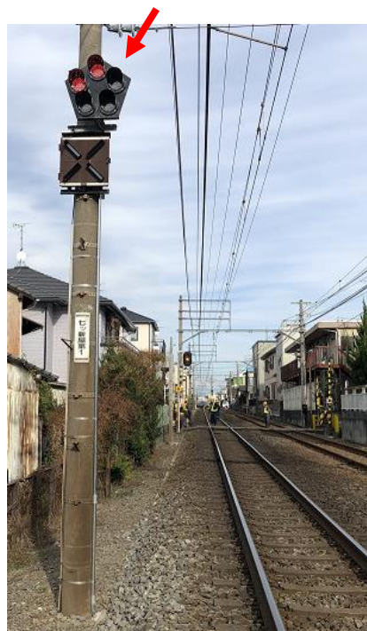
ボタンが押されると踏切付近につけられた信号が点灯し列車に停止を知らせる
