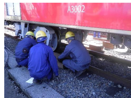
静岡鉄道(株)での 過去脱線復旧訓練の様子
