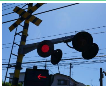
②踏切せん光灯
