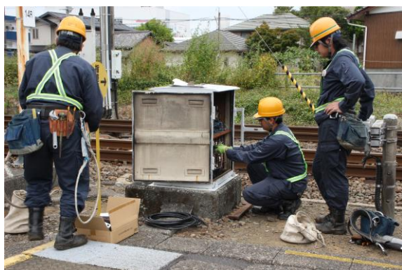
器具箱の作業の様子
