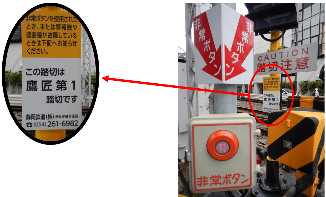
踏切非常ボタン
