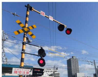
踏切を通行する車の運転手が遠くから踏切を確認できるよう、せん光灯を道路に張り出す形で設置した警報機です。
