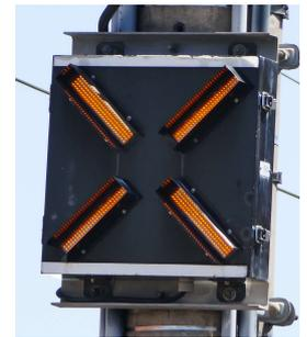
踏切遮断かんが降下し、完全に遮断されると点灯します。LED化により視認性を向上させております。
