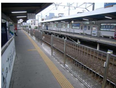
線路への転落防止のため、固定柵を全15駅全てに設置しております。
