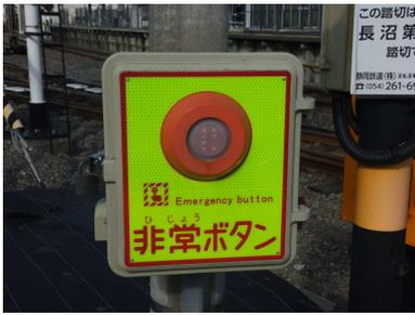
異常時にボタンを押すと接近してくる列車に異常を知らせることができます。全踏切への設置が完了しております。
