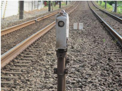
踏切内における障害物をレーザー光線により自動的に検知して、接近してくる列車に異常を知らせる装置です。
