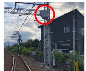
踏切内に停滞した歩行者など、障害物を3Dセンサーで検知して、自動的に列車の運転士に知らせる装置です。
