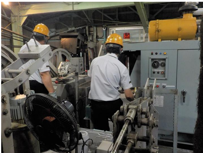
予備原動機の巻き上げを行う様子
