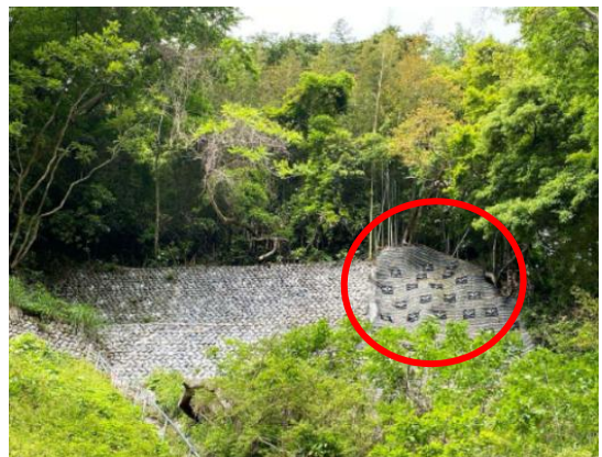
法面復旧工事完了
