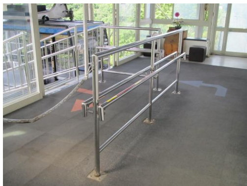
手すり（日本平駅ホーム付近）
