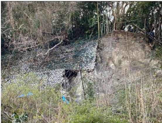
法面の復旧状況（施工中）
