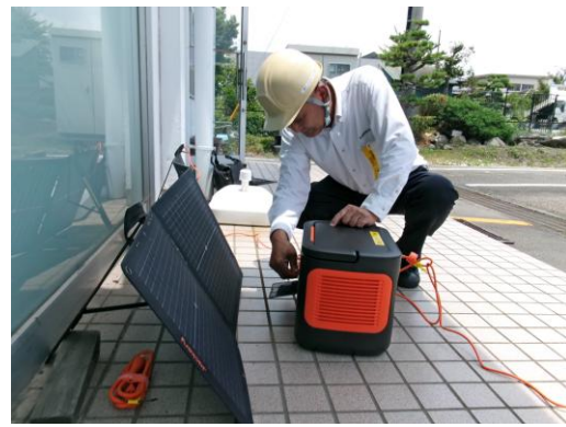
【防災発電機接続訓練】
